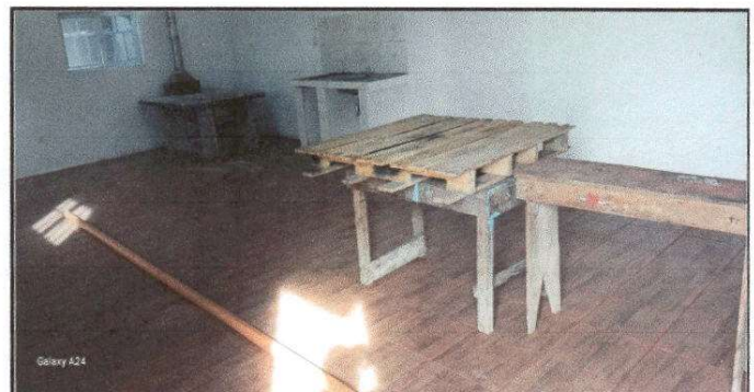
Foto 12: Finalización de Instalación de piso cerámico.
